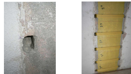
(1)帯シート用貫通孔 (2)シート巻き付け 写真 - 2 施工状況
